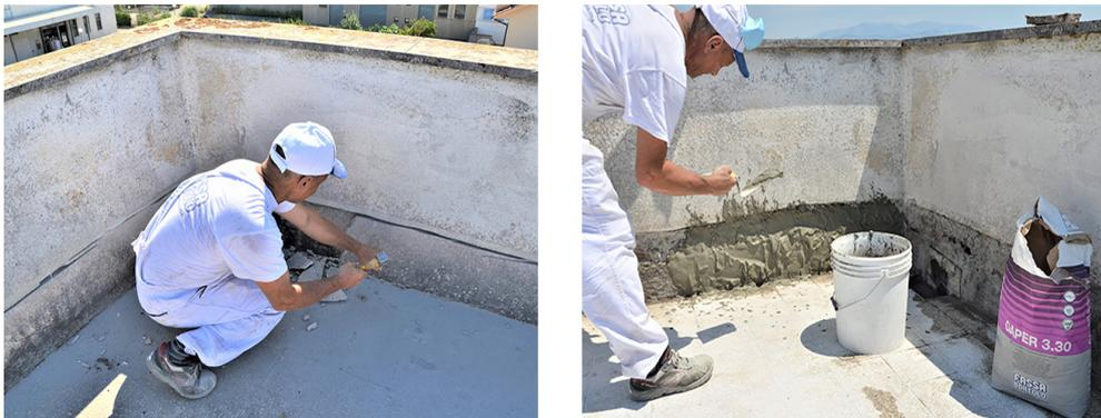
Ao longo das uniões entre o plano horizontal e as faces verticais será posicionada a banda AQUAZIP ELASTOBAND. A banda deverá ser aplicada de modo a assegurar a continuidade nas superfícies de aplicação, aplicando previamente uma camada de pelo menos 2 mm de membrana impermeabilizante AQUAZIP FAST para uma largura que seja superior à da fita, tendo o cuidado de deixar a parte central livre. Para a selagem perfeita dos cantos utilizar os respetivos elementos pré-formados.
