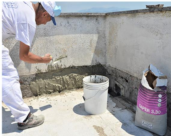
Ao longo das uniões entre o plano horizontal e as faces verticais será posicionada a banda AQUAZIP ELASTOBAND. A banda deverá ser colocada de modo a assegurar a continuidade nas superfícies de aplicação aplicando previamente uma camada de pelo menos 2 mm de membrana impermeabilizante AQUAZIP ONE para uma largura que seja superior à da fita, tendo o cuidado de deixar a parte central livre. Para a selagem perfeita dos cantos utilizar os respetivos elementos pré-formados.
