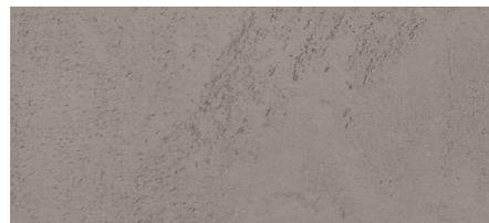
**EFEITO CIMENTO:** na demão final de produto espalhado e ainda fresco traçar veios casuais e descontínuos de modo a simular a textura do cimento tipo face à vista utilizando o respetivo tampão riscado. Quando o produto começar a secar, deve-se compactar e alisar com espátula de inox, até obtermos o grau de acabamento desejado. De acordo com o modo como será realizado o acabamento, podem obter-se diversos efeitos cromáticos claro-escuro.
