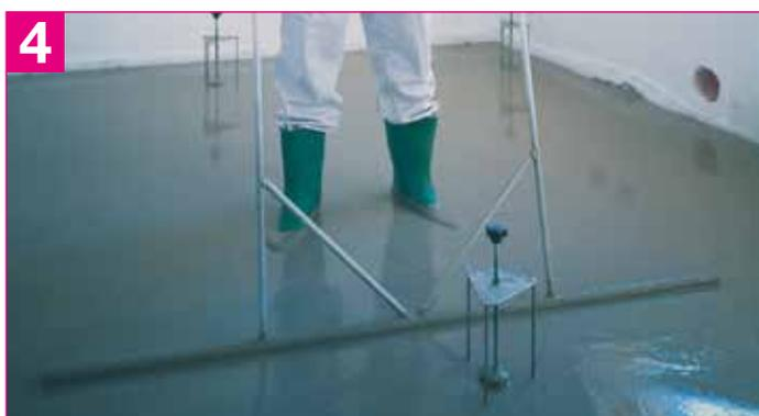
As betonilhas autonivelantes SA 500 são amassadas mediante misturador horizontal e bombeadas para o ponto de aplicação através de máquinas de sem-fim.
