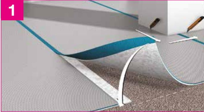
Estender SILENS STA 10 com a camada em fibra (parte branca) virada para baixo, encostando as telas no ponto correspondente às devidas zonas de sobreposição.
