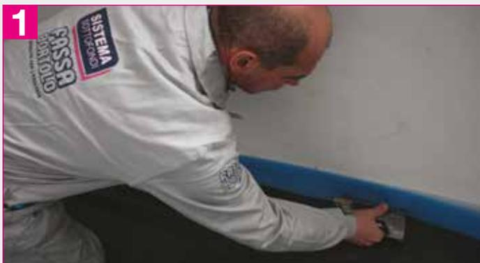
Na falta de prescrições específicas, é necessário espalhar, em toda a superfície a realizar, uma camada separadora não absorvente adequada com função de travão de vapor, sobrepondo as junções em pelo menos 10-15 cm e prosseguindo ao longo da parede. Ao longo das paredes perimetrais e dos elementos em elevação, deve dispor-se uma fita de material comprimível com 0,5-1 cm de espessura e pelo menos tão alto quanto a betonilha a realizar.
