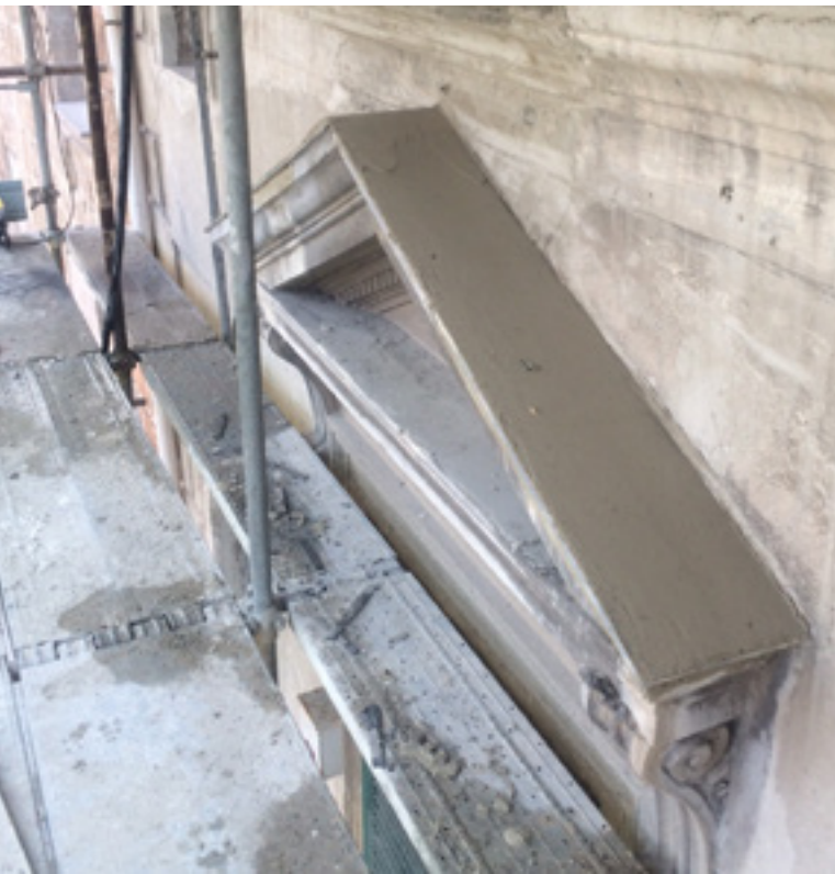
Ripristino di cornice con SPECIAL WALL B 550 M
